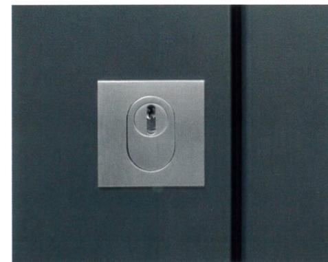
Türblatt und Stockrahmen nahezu flächenbündig
